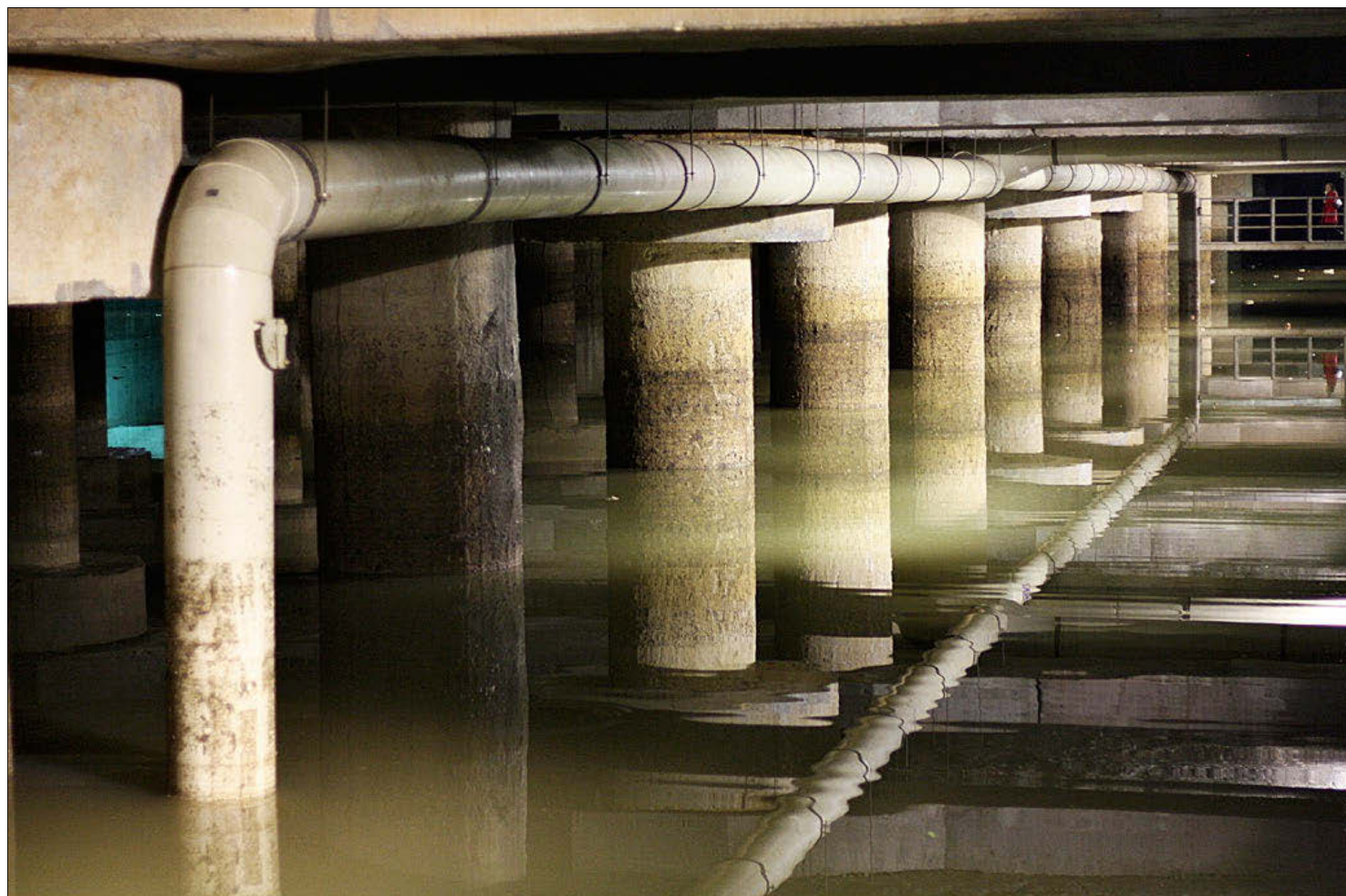
Estado actual del tanque de tormentas de Arroyofresno, el que más capacidad tiene en la región. FOTO: CANAL DE ISABEL II
