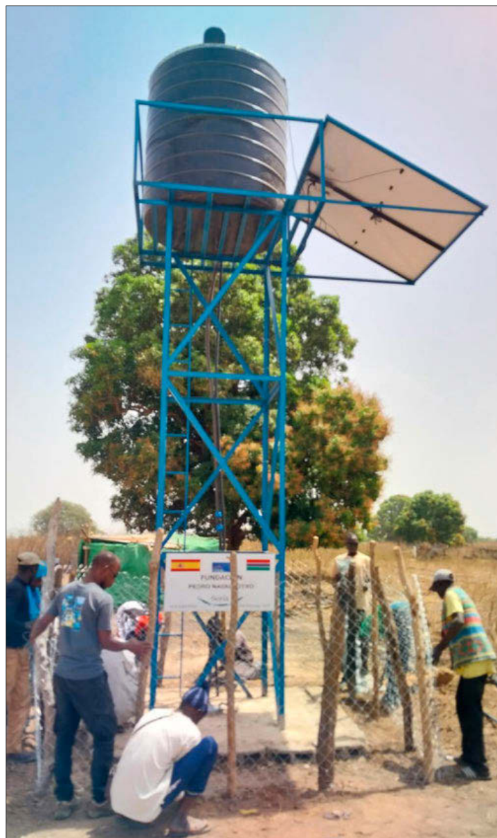
Imagen de la cisterna construida. HDS
